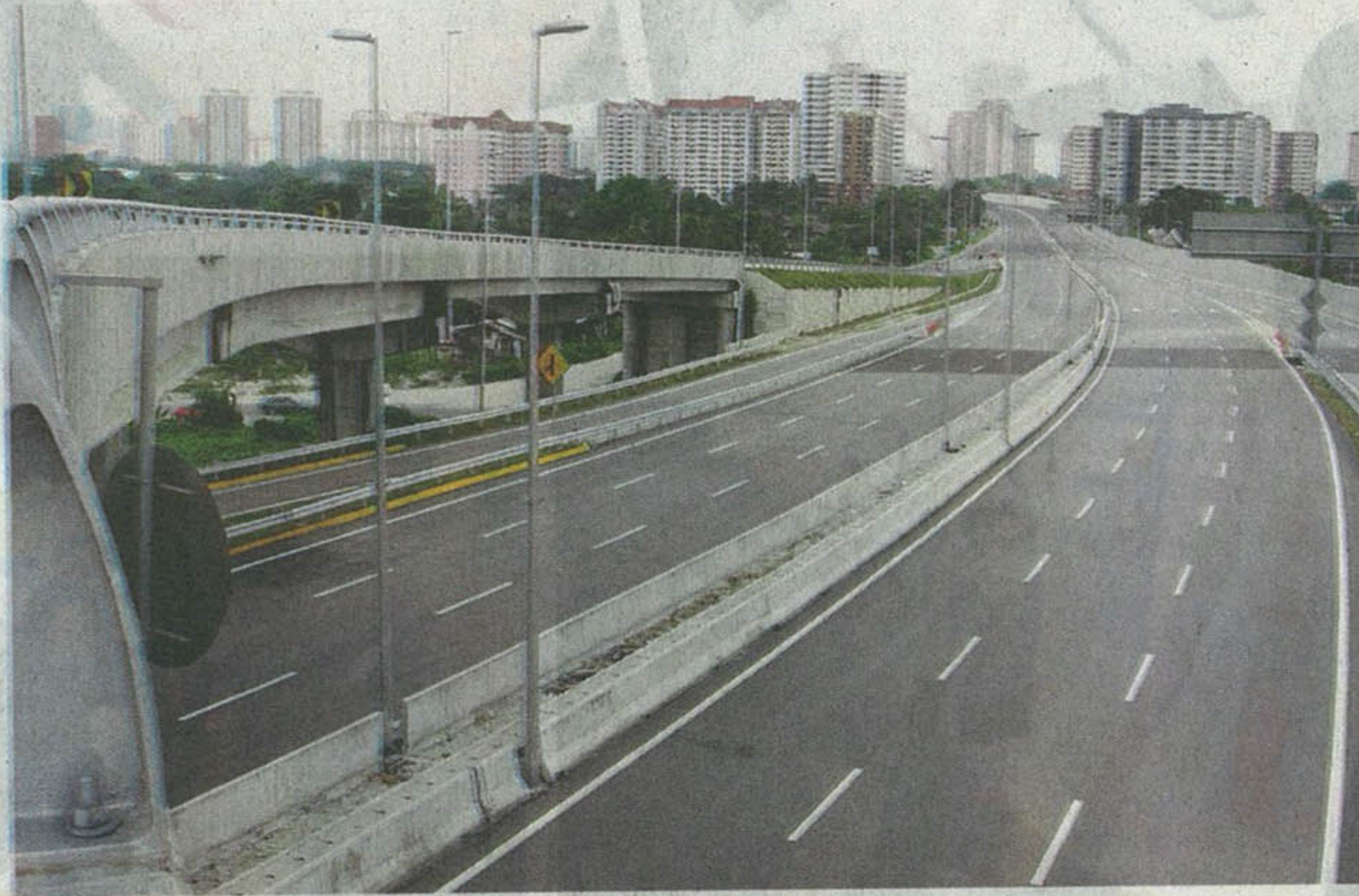
HUBUNGAN Duta yang menyambungkan Lebuhraya DUKE dengan Jalan Duta yang boleh mula digunakan hari ini.
